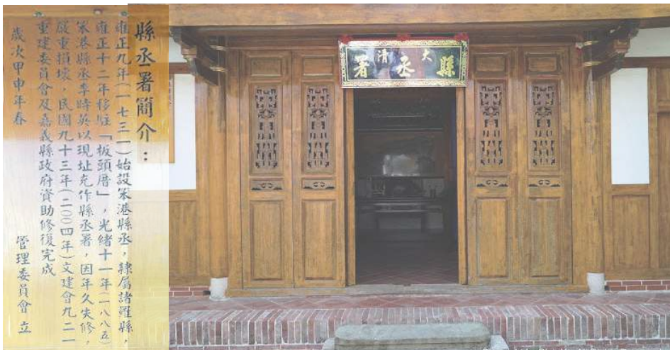
縣丞署（於民國93年修復完成）
